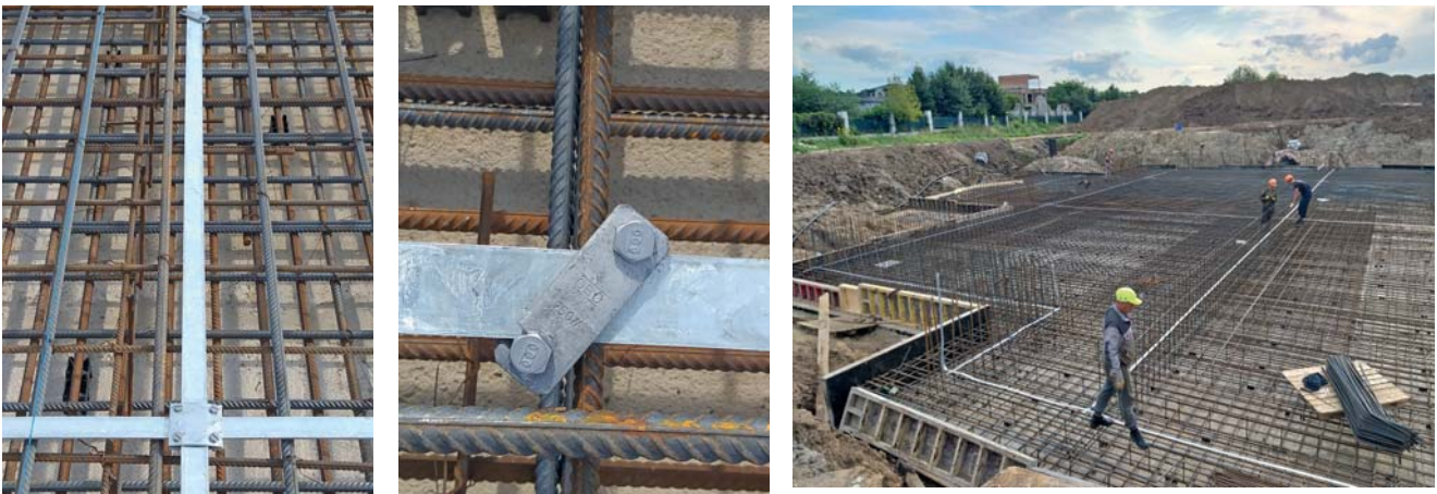
Монтаж фундаментного заземления в жилом комплексе «Парк Вилл», Московская область, Россия
