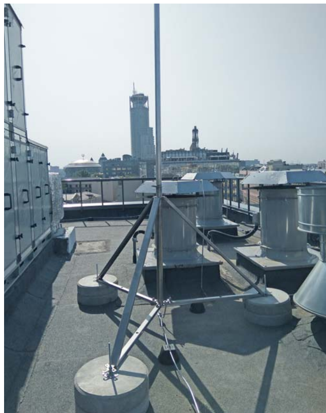
Молниеприемная мачта isFang на кровле жилого комплекса на Садовнической, г. Москва, Россия
