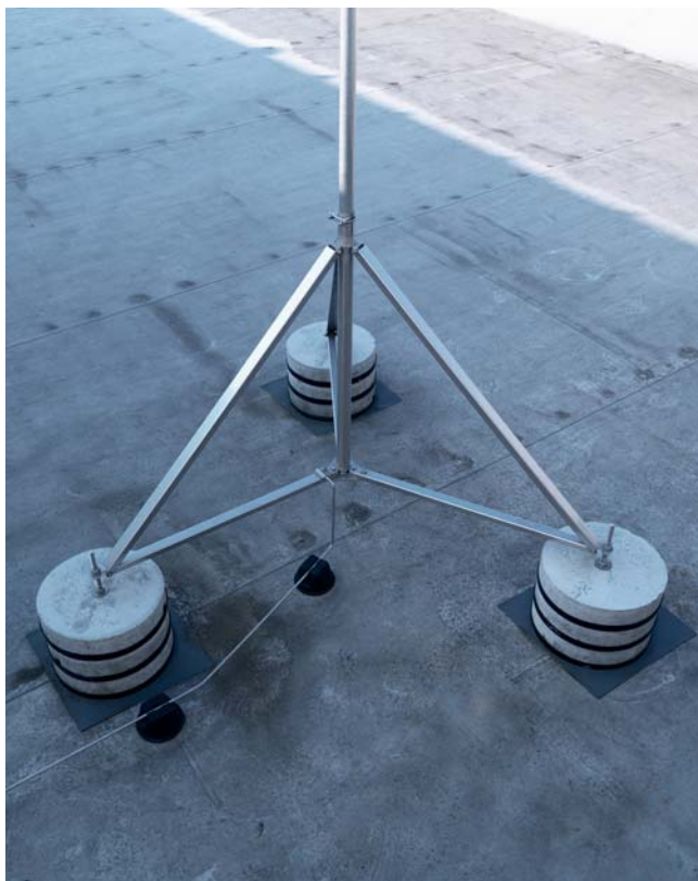
Молниеприемная мачта isFang на кровле жилого комплекса на Садовнической, г. Москва, Россия
