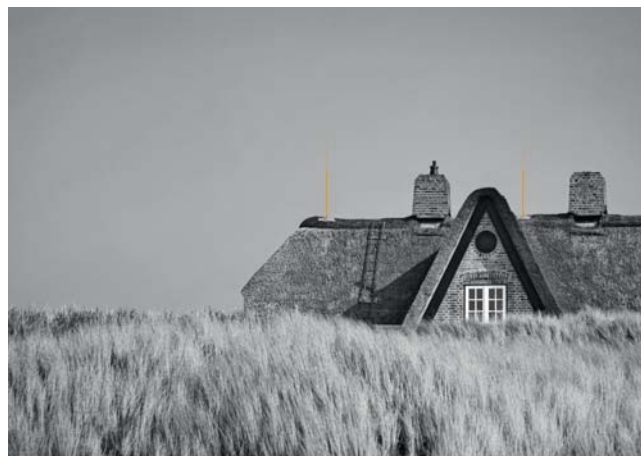
Рис. 2.71: Крыша с мягким покрытием с проводом isCon®
