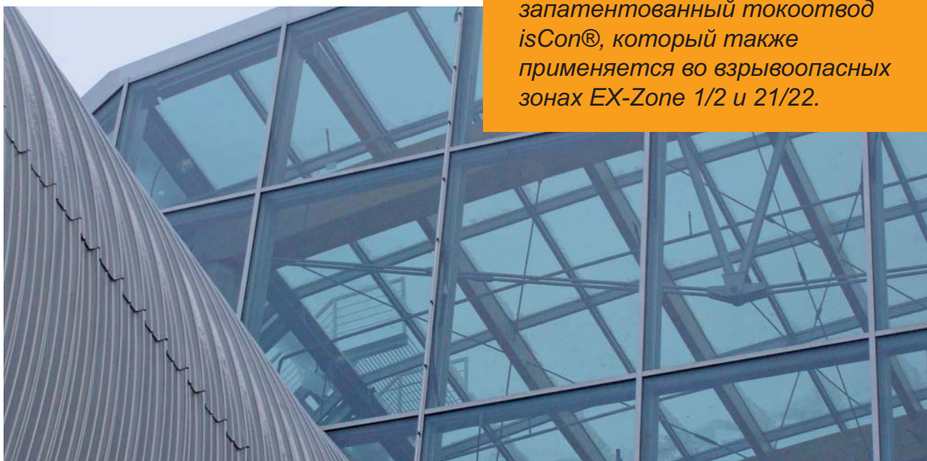
Крепление токоотводов системы внешней молниезащиты на раму стеклянного фасада торгового центра «Ауга», г. Санкт-Петербург, Россия
