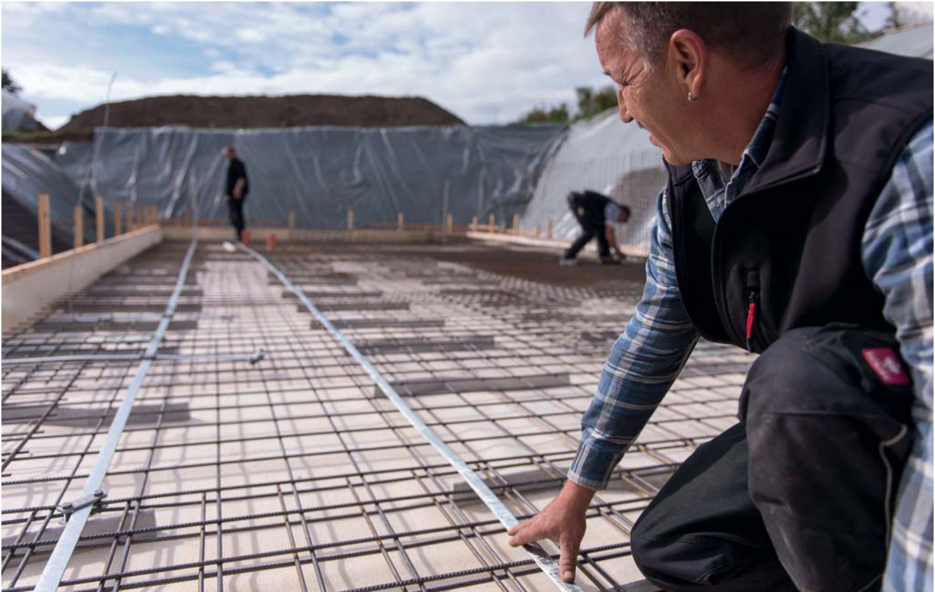
Рис. 2.75: Прокладка фундаментного заземлителя
