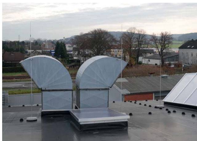
Рис. 2.24: Изолированная система со стеклопластиковыми держателями
