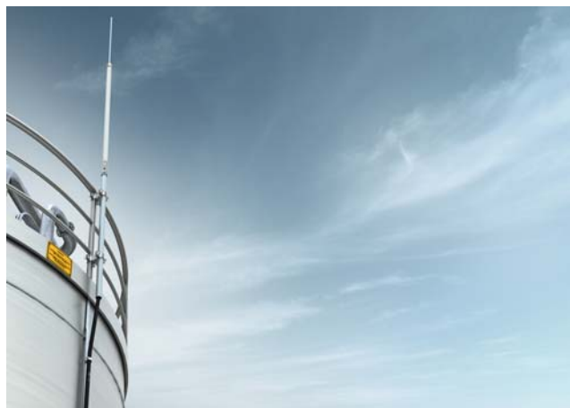
Рис. 2.58: Изолированная молниезащита с токоотводом isCon®
