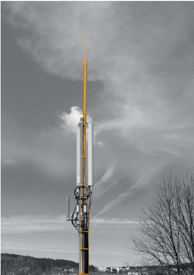
Рис. 2.72: Мачта мобильной радиосвязи с токоотводом isCon®
