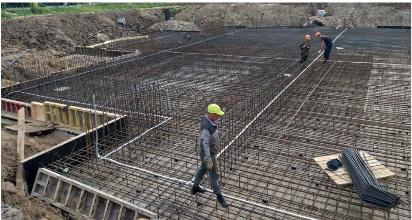
Рис. 2.82: Кольцевой заземлитель типа В
