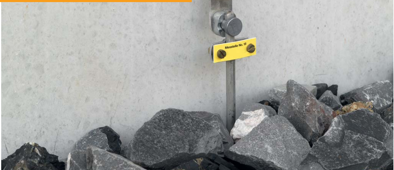
Рис. 2.48: Точка измерения на вводе в землю
