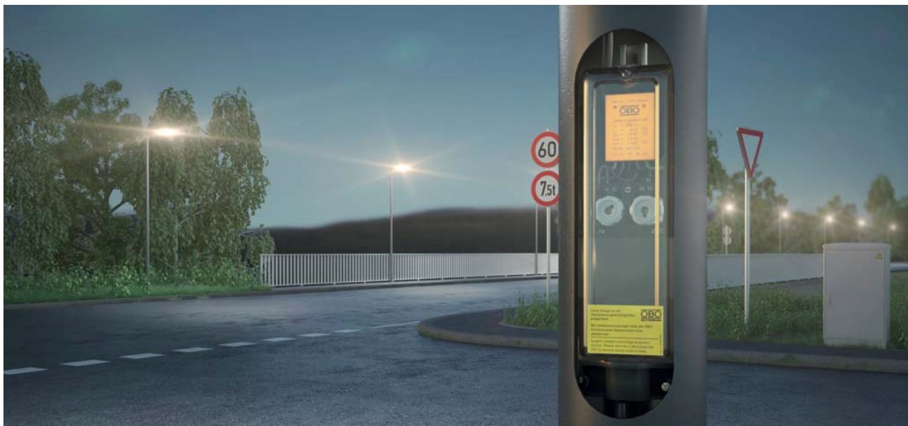
Рис. 3.25 Пример применения устройства защиты от перенапряжений для светодиодных систем
