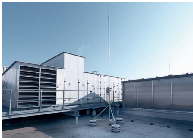
Рис. 2.22: Изолированная молниезащита с молниеприемной мачтой isFang
