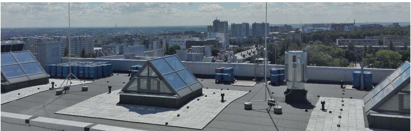
Молниезащита светоаэрационных фонарей и других надстроек на кровле торгово-развлекательного центра «Мега Гринн Курск», г. Курск, Россия
