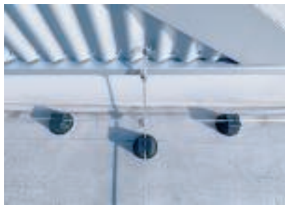
Соединение металлического фасада с системой молниезащиты
