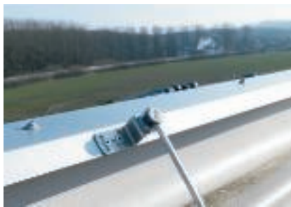
Соединение аттика с системой молниезащиты
