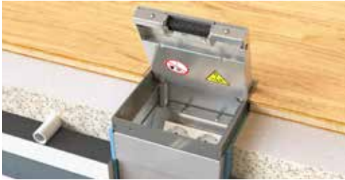
1 Стяжка в бетоне
