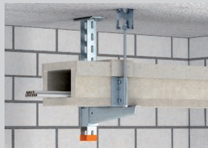
Монтаж короба с классом огнестойкости E с дополнительной фиксацией стержнем с резьбой.
