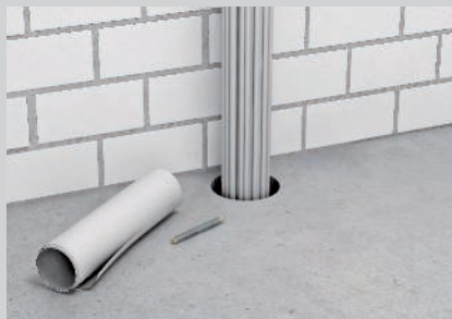
Подготовка кабельной проходки.
