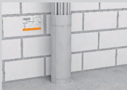
Закрытие оставшегося отверстия проходки шпатлевкой и монтаж идентификационной таблички.
