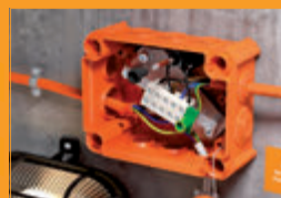
Ввод кабеля с помощью вставных уплотнителей.
