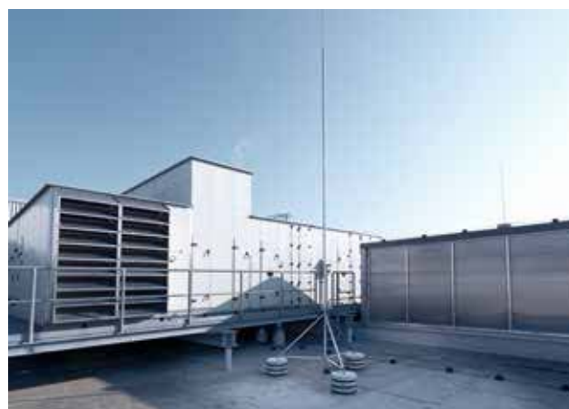
Рис. 2.22: Изолированная молниезащита с молниеприемной мачтой isFang
