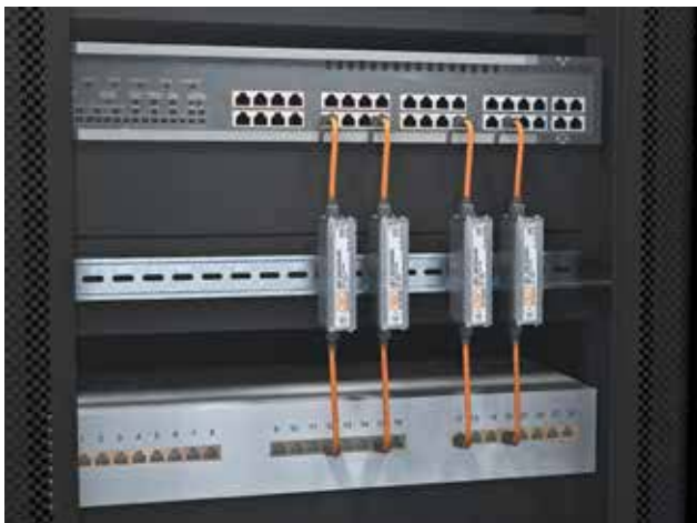
Рис. 3.81 Рекомендация по защите на коммутаторе с коммутационной панелью. УЗИП заземлены через U-образную шину.
