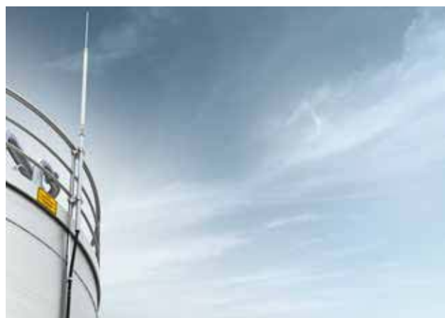
Рис. 2.58: Разделенная молниезащита с проводом isCop®
