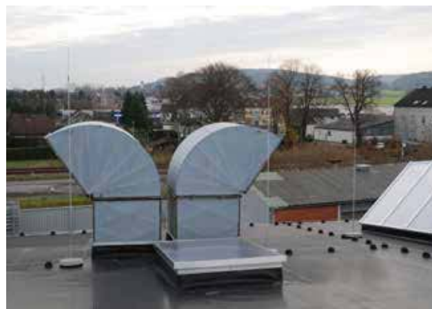
Рис. 2.24: Разделенная система со стеклопластиковыми держателями
