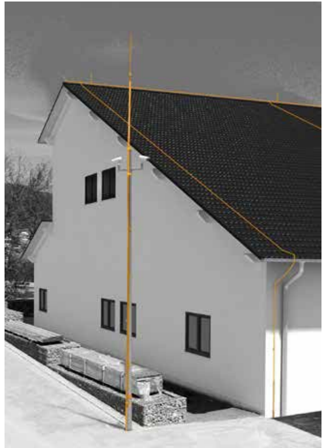
Рис. 2.73: Камера видеонаблюдения с проводом isCon®
