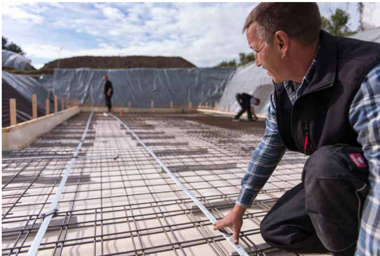
Рис. 2.75: Прокладка фундаментного заземлителя
