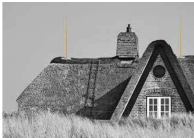
Рис. 2.71: Крыша с мягким покрытием с проводом isCon®
