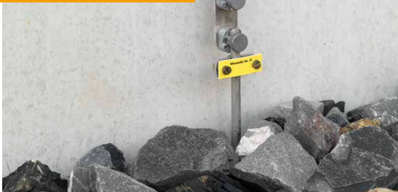
Рис. 2.48: Точка измерения на вводе в землю
