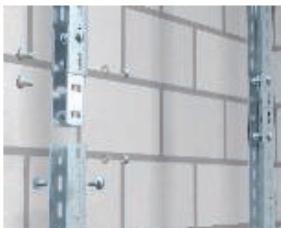
Соединение U-стоек Для соединения U-образных стоек применяются соответствующие соединители VUS 3, VUS 5 и VUS 7.
