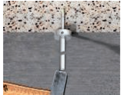
Установка распорного дюбеля BZ IG Вбить распорный дюбель тип BZ-IG соответствующим инструментом. Затем прикрепить скобу.
