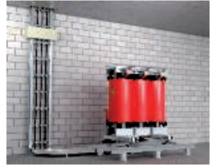
Монтаж отдельно расположенных вертикальных кабельных лотков лестничного типа
