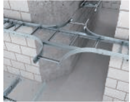
Создание крестообразной секции Монтаж двух секций тип LAA для создания крестообразной секции.
