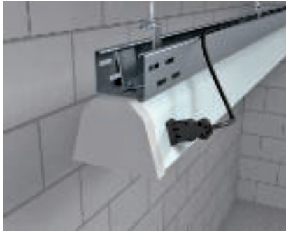
Предварительно собранные кабельные лотки для монтажа светильников Монтаж собранного светильника под кабельным лотком.
