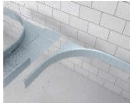
T-образное ответвление с помощью угловой секции Монтаж второго элемента угловой секции WEAS 110.
