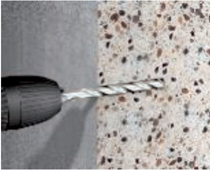
Просверлить дюбельное отверстие Просверлить отверстие соответствующего диаметра и глубины.
