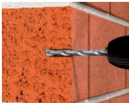
Просверлить дюбельное отверстие Просверлить отверстия соответствующего диаметра и глубины.
