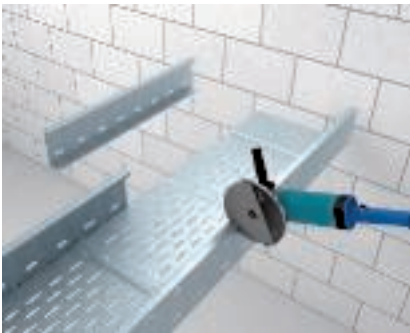
T-образное ответвление с помощью угловой секции Извлечение боковых стенок кабельного лотка для больших расстояний.
