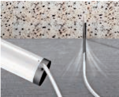
Продувка отверстия Удалить пыль из отверстия.
